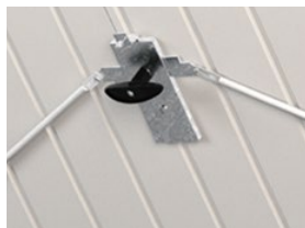
Serrure avec cylindre pour verrouiller la porte des deux côtés
