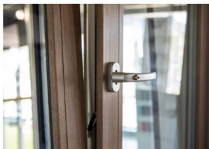
Cette solution est conçue pour verrouiller l'ouvrant en position oscillante après avoir tourné la poignée de 90 degrés à l'horizontale, ce qui empêche l'ouvrant de passer de la position oscillante à la position ouverte de la fenêtre. Ce n'est qu'après avoir déverrouillé la poignée avec la clé qu'on a la possibilité d'ouvrir la fenêtre. Cette solution garantit la sécurité des enfants et permet en même temps d'aérer la pièce lorsque la fenêtre est entrebâillée.
